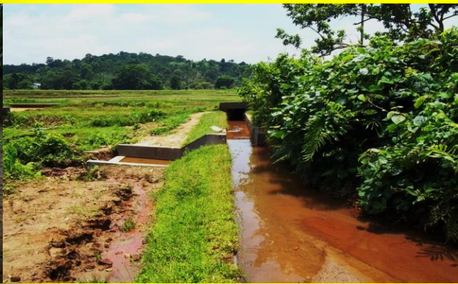
CC Check Dam at Chenggal m/watershed, IWMP-II
